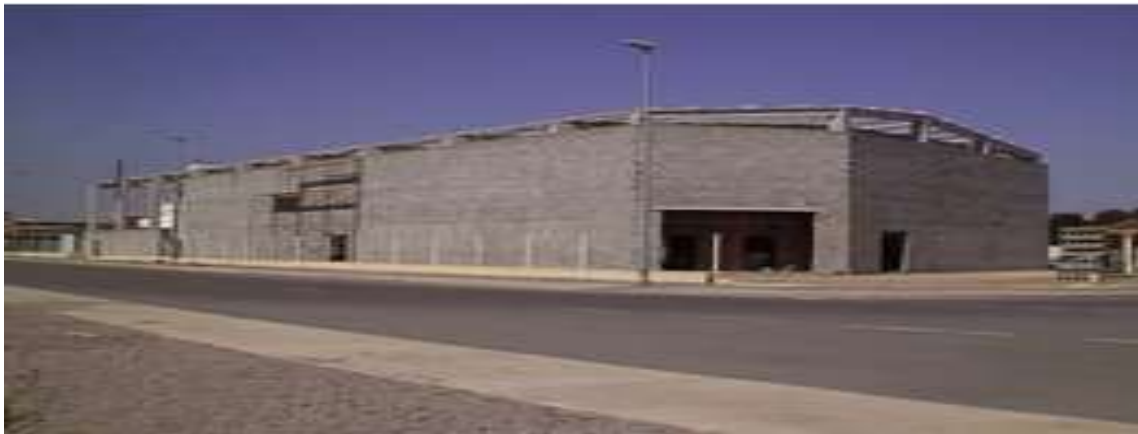
DISCOTECA J.J.M. (KALYPSO) PUERTO DE SAGUNTO (VALENCIA) 700 m2 CONSTRUIDOS
