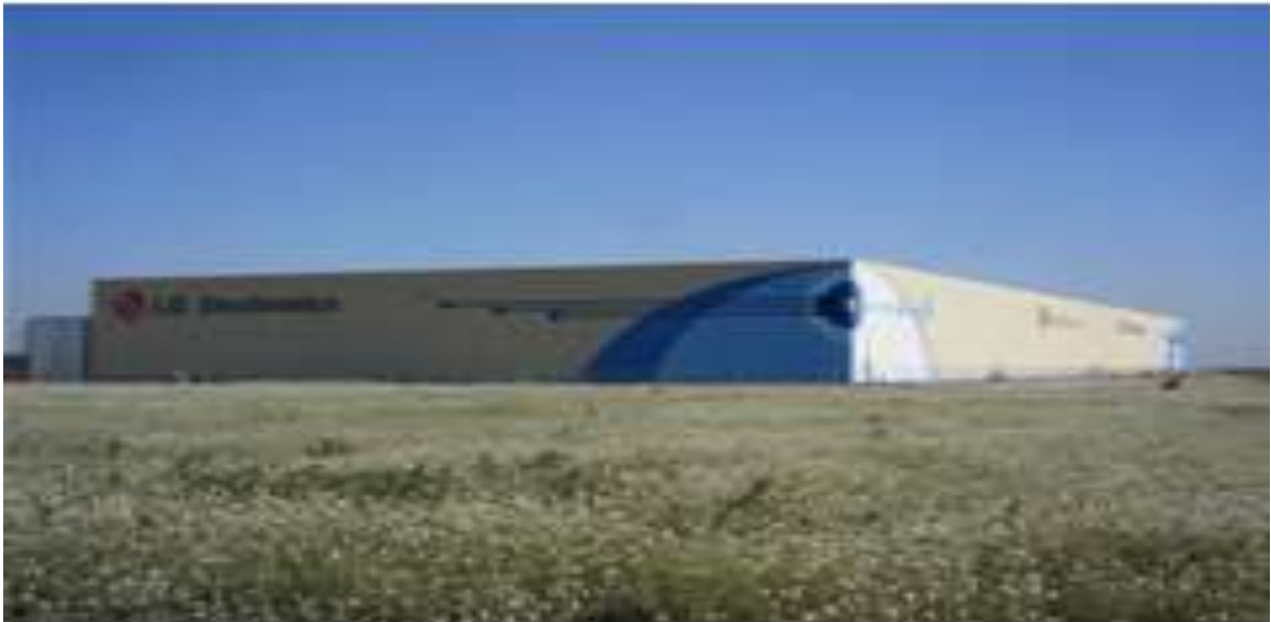
LG ELECTRONICS, S.A. ALMACÉN DE ELEMENTOS ELECTRÓNICOS RIBARROJA DEL TURIA (VALENCIA) 16.000 m 2 CONSTRUIDOS
